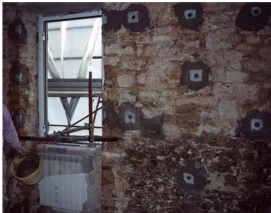
**Foto 1:** preparazione di una parete con presentazione degli elementi imbutiti e degli angolari.
