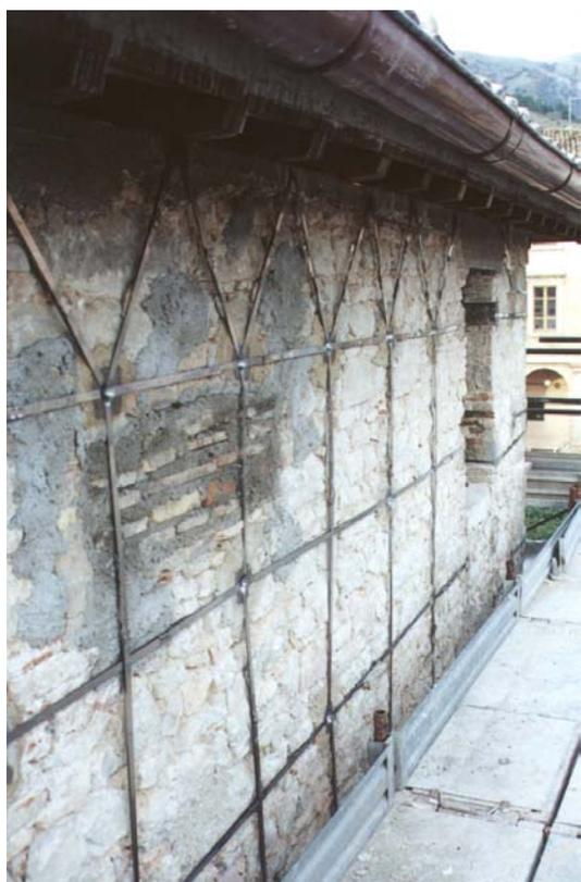
**Foto 6:** disposizione delle maglie in corrispondenza della legatura del cordolo di sottotetto.
