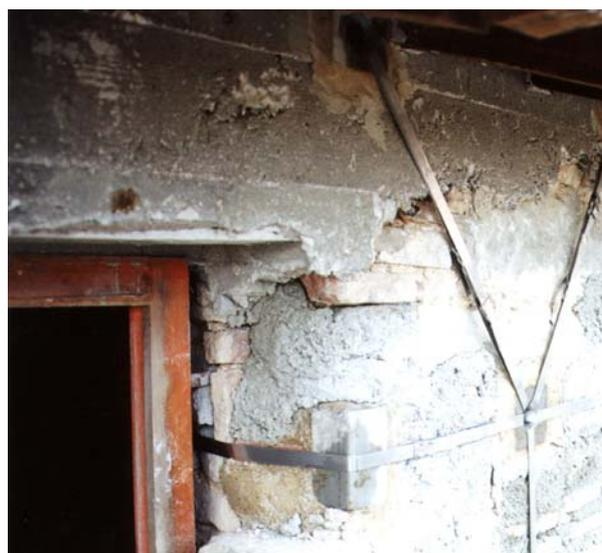
**Foto 5:** Particolare del collegamento del cordolo di sottotetto e andamento della maglia orizzontale in corrispondenza del vano finestra.
