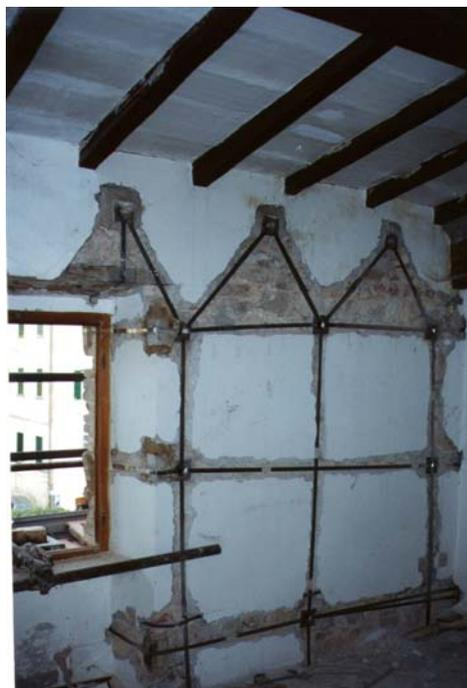
**Foto 14:** si apprezza la posa lungo le tracce d'intonaco con continuità verticale del collegamento fino al cordolo
