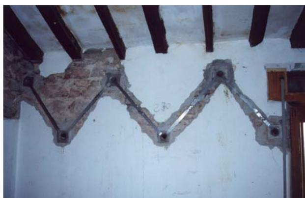
**Foto 7:** disposizione per maglie inclinate, su traccia.
