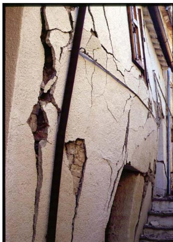
Fig. 4 – Spanciamento per instabilità del paramento murario esterno.
