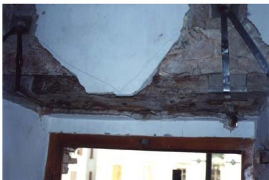
**Foto 8:** legatura e rinforzo nella zona di architrave di un vano finestra, senza sostituzione dello stesso.
