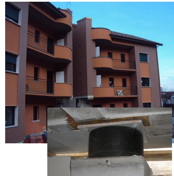
Condominio Borgo dei Tigli, L'Aquila (adeguamento con isolamento sismico)
