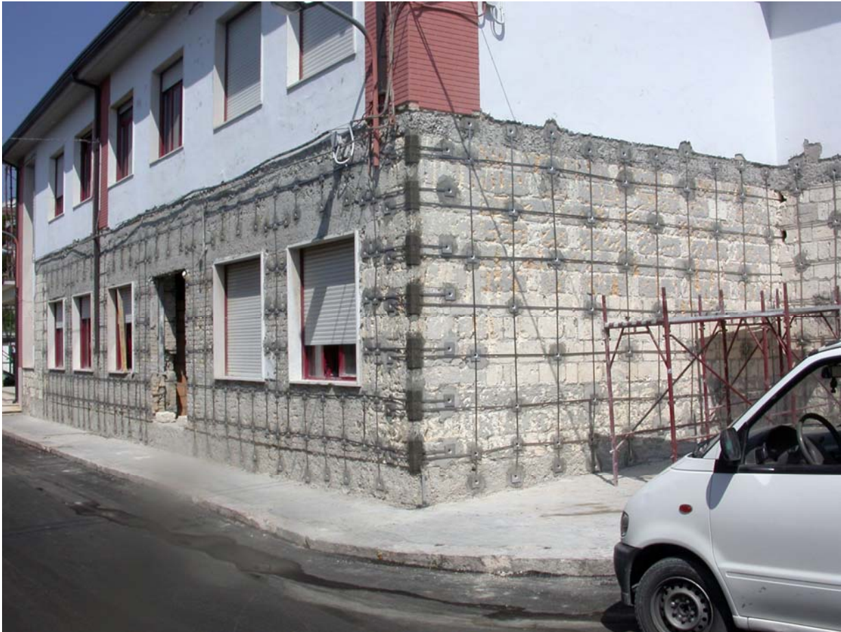
Miglioramento sismico della scuola elementare del comune di Castelluccio Valmaggiore (FG): applicazione del sistema C.A.M.
