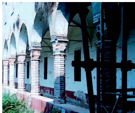
Fig. 8 – Vista del colonnato del chiostro dopo l'intervento di cerchiatura sulle colonne.
