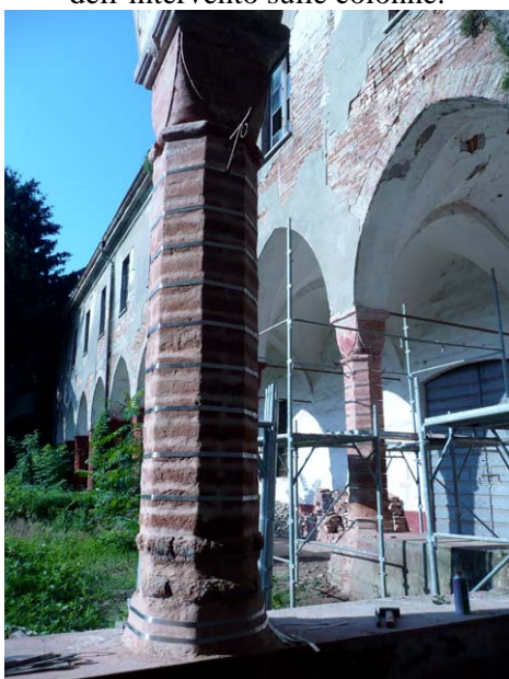
Fig. 9 – Intervento di cerchiatura con il CAM sulla singola colonna.
