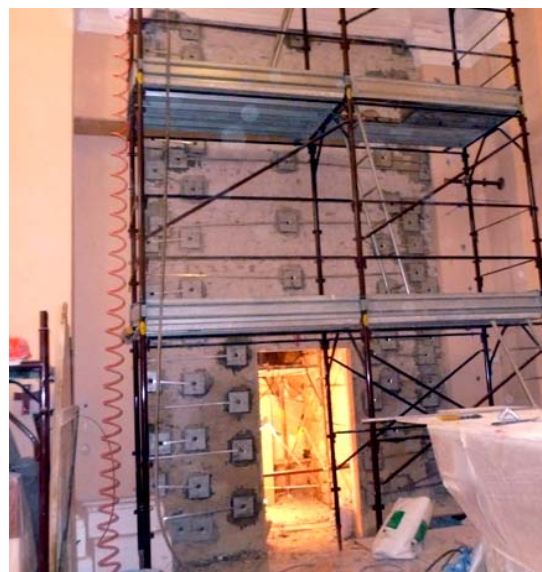
Fig. 6 - Applicazione del CAM: vista dall'interno della chiesa di una parete comune a chiesa e campanile.
