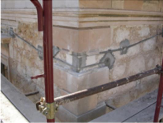
*Elemento di bugnatura parzialmente asportato per permettere il passaggio della tirantatura*
