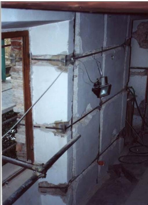
**Foto 6:** disposizione delle maglie su preparazione per tracce, senza rimozione completa dell'intonaco.
