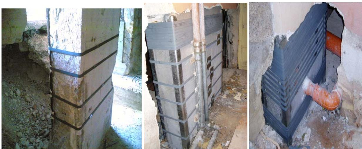
**Foto 8: PALERMO – Edificio in c.a. di n° 13 piani con tutti i pilastri del piano cantinato senza staffe.**
