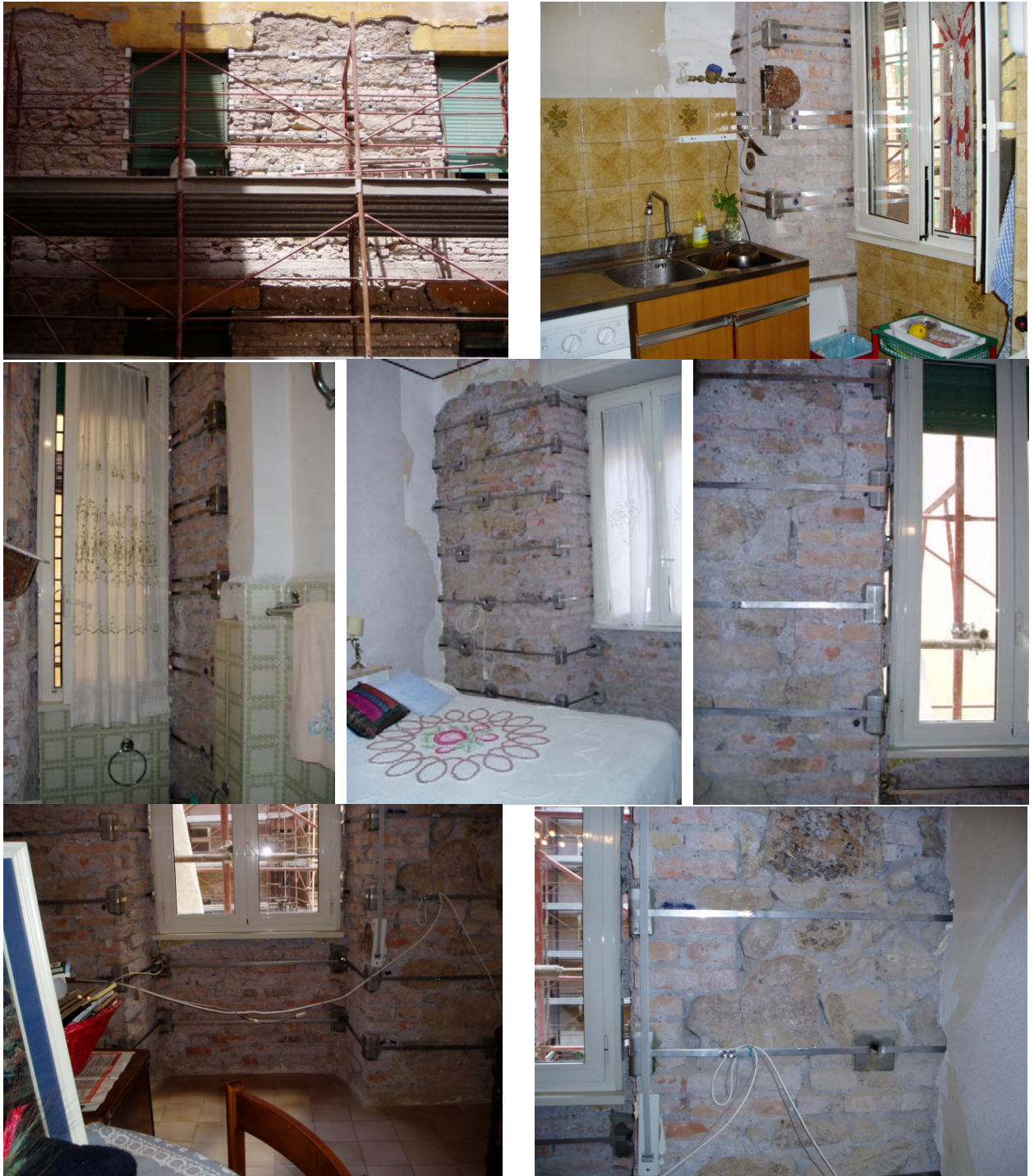
Foto 11: Intervento di cerchiaggio reso necessario a causa del progressivo dissesto per schiacciamento dei maschi murari (cantiere Roma immobile 7 piani).
