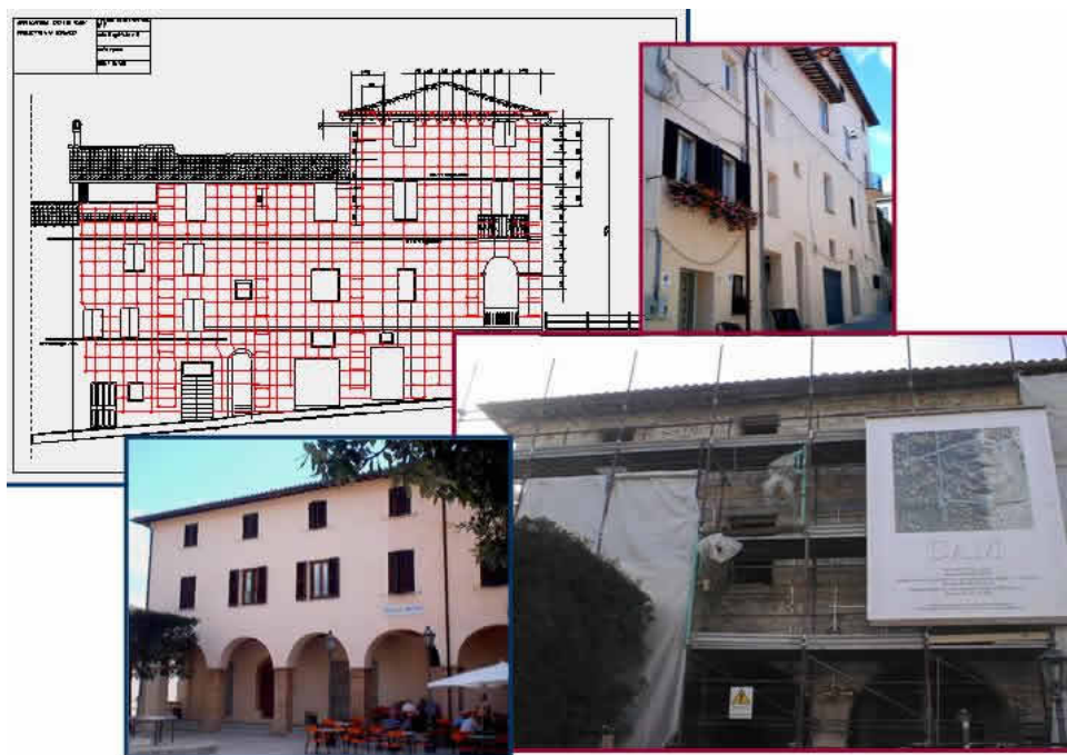
Foto 10: (Legge 61/98 – Ricostruzione terremoto Umbria-Marche del 26.09.02) SIGILLO (PG) – Edificio storico del XIX secolo (1818) in P.zza dei Martiri 166, colpito dal terremoto del 26.09.02
