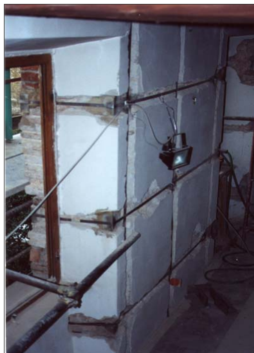
Foto 8: disposizione delle maglie su preparazione per tracce, senza rimozione completa dell'intonaco.
