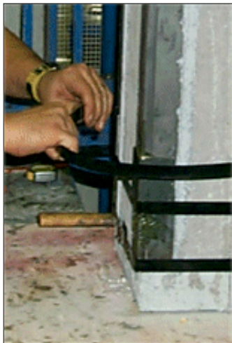
Fig. 2.1 Applicazione del sistema CAM alle colonne in c.a.
