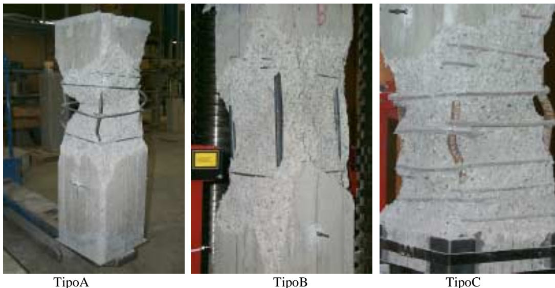
Fig. 5.1 Tipiche rotture riscontrate nelle colonne non rinforzate con CAM
