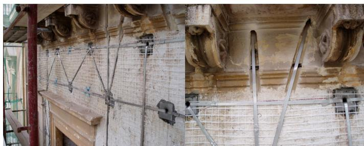
Cordolo tipo alla Giuffrè ai piani intermedi in continuità con la maglia diffusa applicata all'intero prospetto alto 15 m per la sua messa in sicurezza prima della demolizione della parte interna del fabbricato e la successiva costruzione dell'edificio in C.A. (Vittoria).
