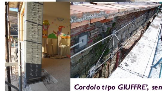
*Pilastro rinforzato con Sistema CAM (Scuola elementare Crespadoro (VI))*
