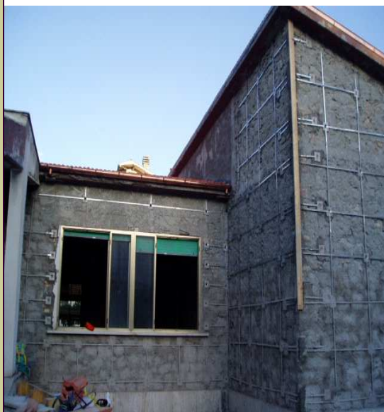
Adeguamento sismico di edificio scolastico in muratura, durante la chiusura estiva, senza lo smontaggio degli infissi e degli impianti. (Molise)
