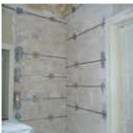
Collegamenti attivi tra setti murari (Vittoria)
