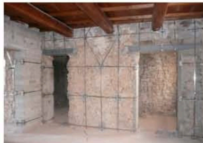
Fabbricato detto "I Magazzini" a Contigliano dell'ATER di Rieti: il consolidamento delle murature in pietra
