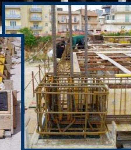
*Fasi relative alla posa ed alla realizzazione della struttura in corrispondenza di un isolatore*
