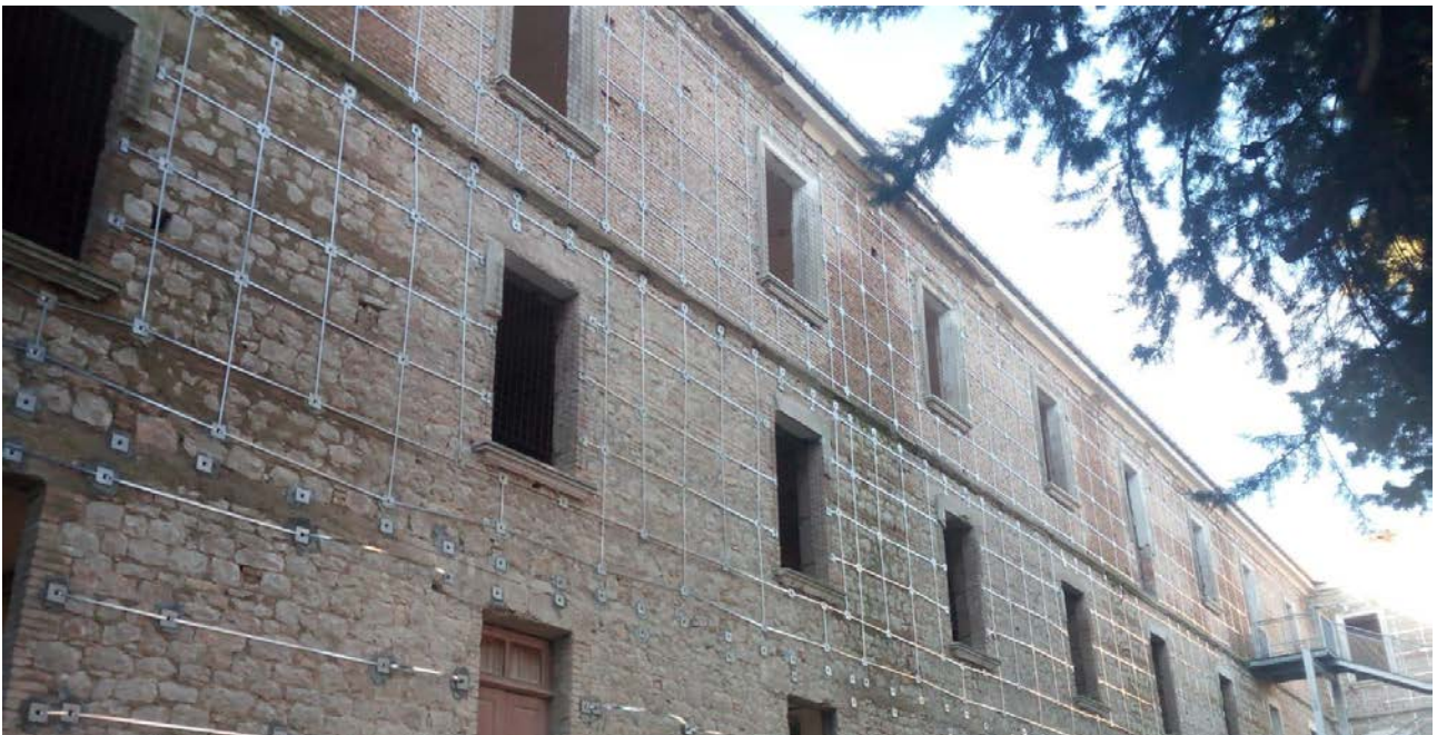
Lavorazione Edil CAM Sistemi s.r.l. su facciata di un edificio scolastico
