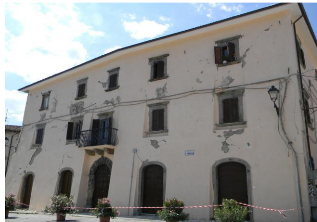
Rotture duttili su edifici in muratura
