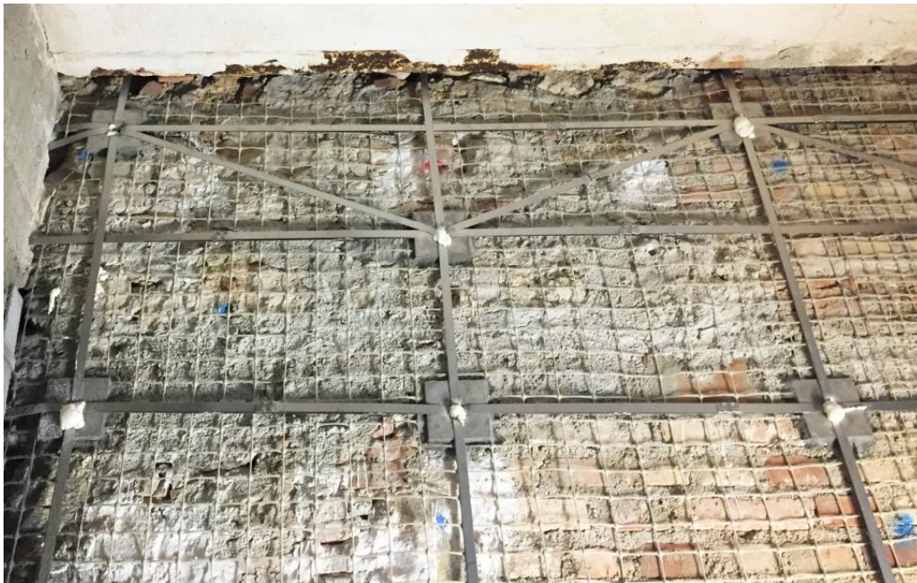
Applicazione EDIL CAM Sistemi con reticolo CAM® in combinazione alla rete TENAX-RF2
