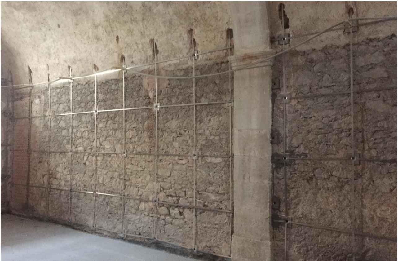
Lavorazione Edil CAM Sistemi s.r.l. su fabbricato storico
