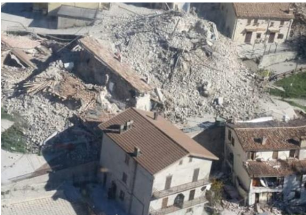
Rotture fragili su edifici in muratura
