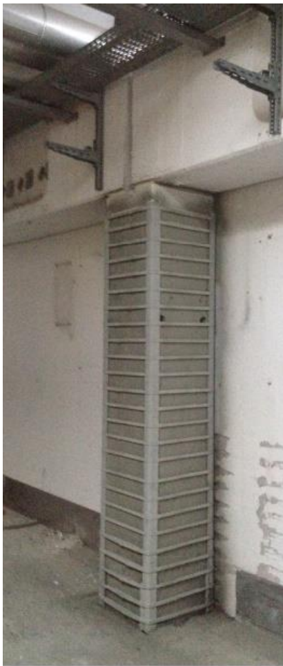
Pilastro in corrispondenza di pannelli perimetrali non rimossi
