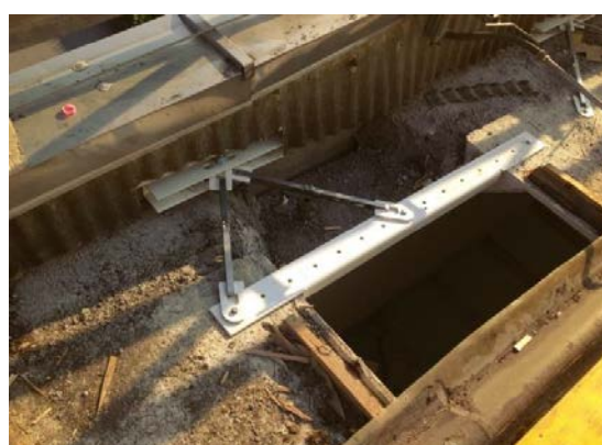
Intervento EDIL CAM SISTEMI di connessione tegolo-pannello
