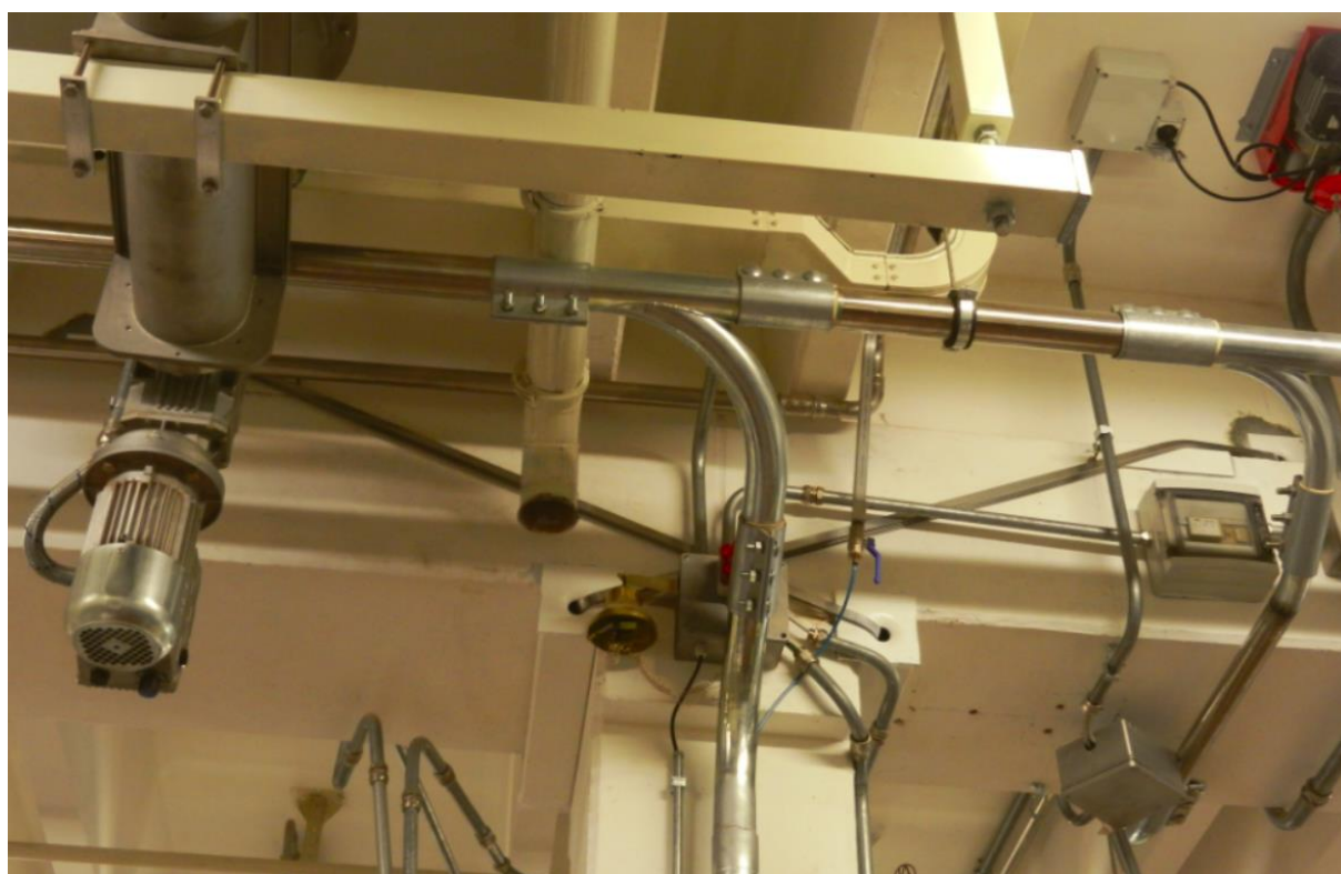
Interventi EDIL CAM SISTEMI di connessione pilastro-trave
