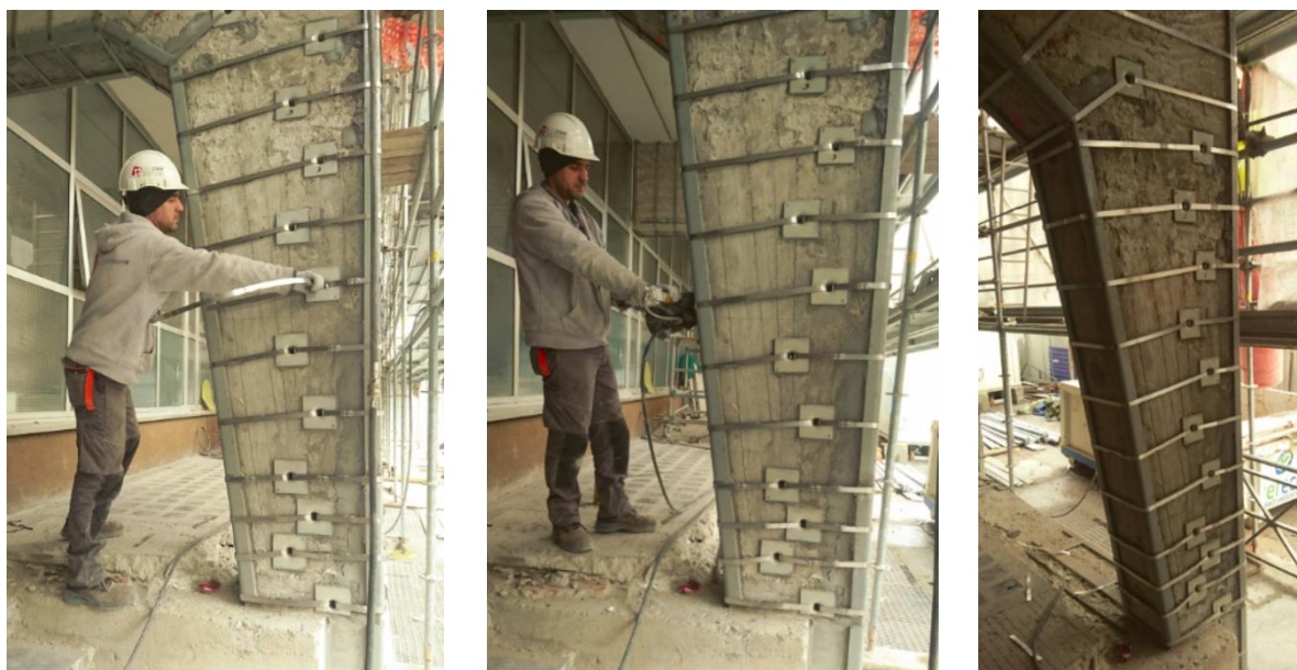
Pilastro di dimensione variabile durante le fasi di applicazione di posa e tesatura del nastro
