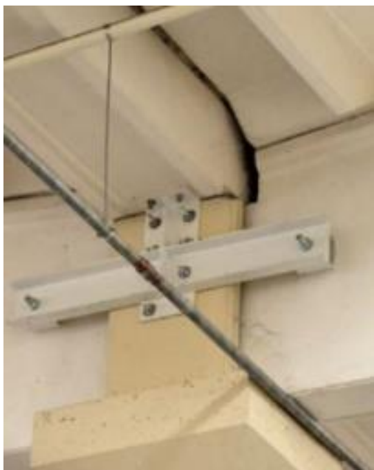
Carpenteria metallica per realizzazione dei vincoli
