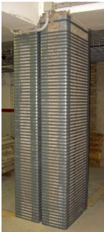
Pilastri in corrispondenza di un giunto strutturale
