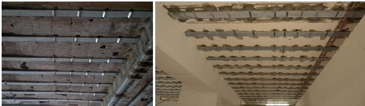
Interventi EDIL CAM SISTEMI su solai: vista intradosso solaio
