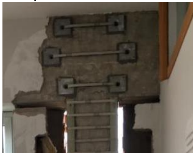
Interventi di NODO mediante Sistema CAM ®
