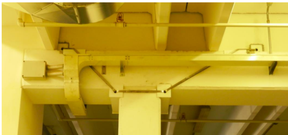
Interventi EDIL CAM SISTEMI di connessione pilastro-trave
