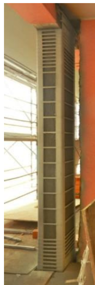
Pilastro con 'staffatura' maggiorata nelle zone critiche
