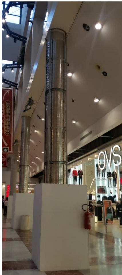
Pilastro circolare rinforzato in un CC senza interruzione dell'attività
