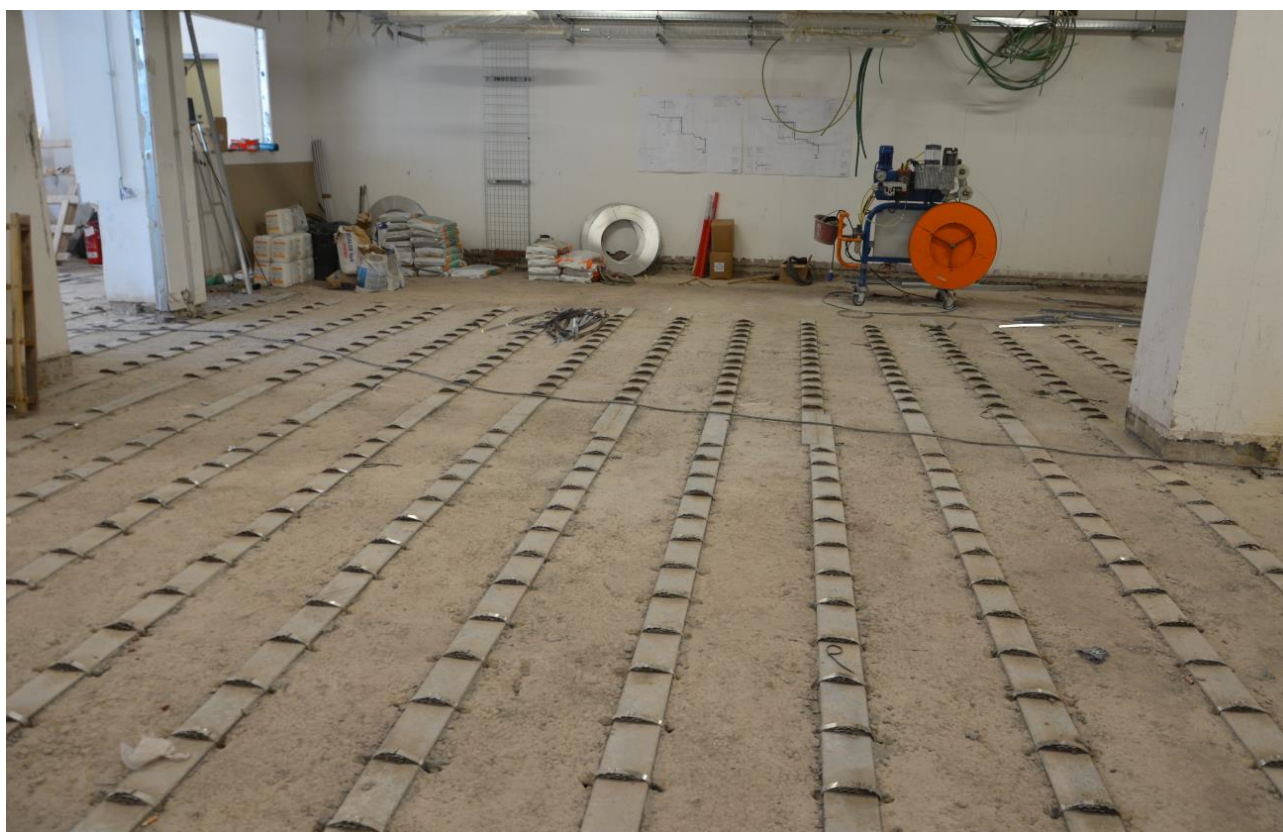
Interventi EDIL CAM SISTEMI su solai: vista estradosso solaio
