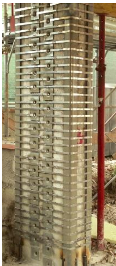
Pilastro con 'staffatura a più braccia'
