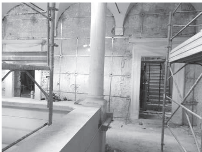
Castello Rivera (AQ) – vista del patio centrale
