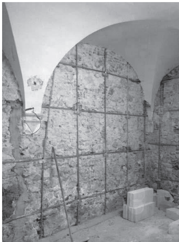
Il Castello Rivera (AQ) – Sistema CAM®. Applicazione regolare a doppio ordito
