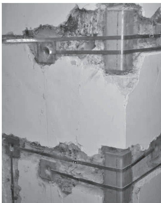
Il Castello Rivera (AQ) – Sistema CAM®. Incatenamento delle pareti d'angolo. Si noti che l'intonaco è rimosso solo per tracciatura.
