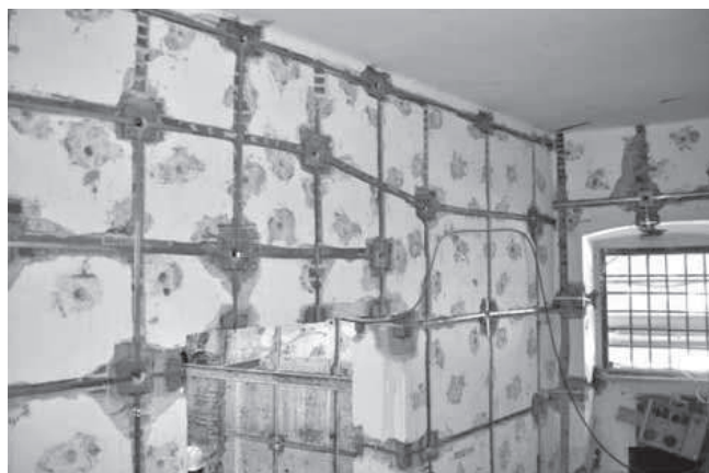
Il Castello Rivera (AQ) – Sistema CAM®. Applicazione regolare a doppio ordito
