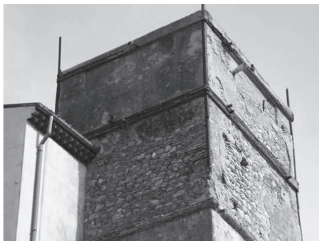
Ururi (CB) – Campanile della Chiesa di S. Maria delle Grazie. Esempio di aggregato irregolare
