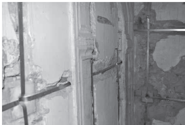
Castello Rivera (AQ) – particolare dell'attraversamento delle lesene con ancoraggio del blocco lapideo
