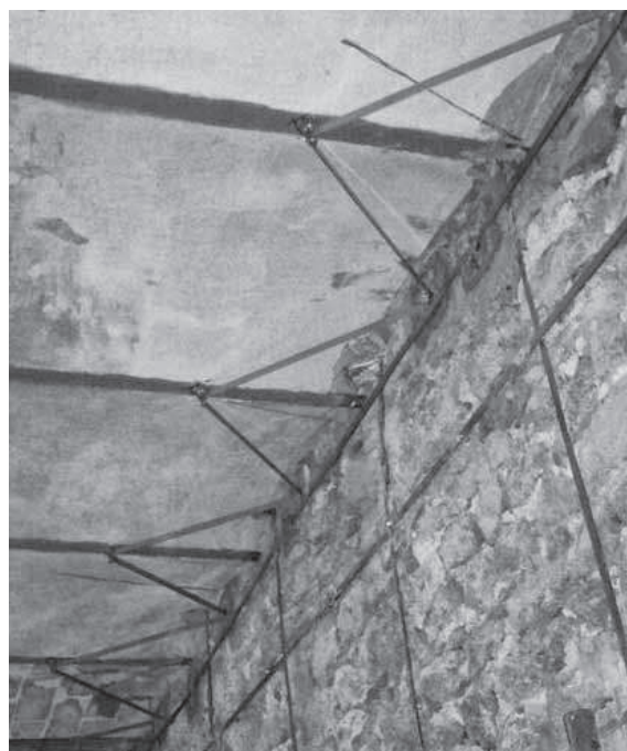
Il Castello Rivera (AQ) – Sistema CAM ® . Distribuzione a progetto a doppio ordito e arpionatura delle travi di solaio
