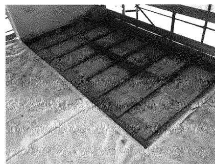
Foto F - rinforzo trave tramite placcaggio continuo con acciaio
