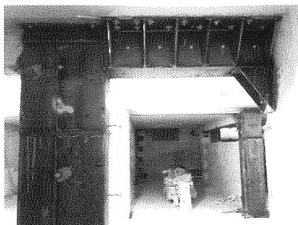
Foto D - rinforzo trave e pilastro tramite placcaggio continuo con acciaio
