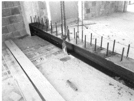
Foto H - intervento per inserimento di travi in acciaio HEB 300
