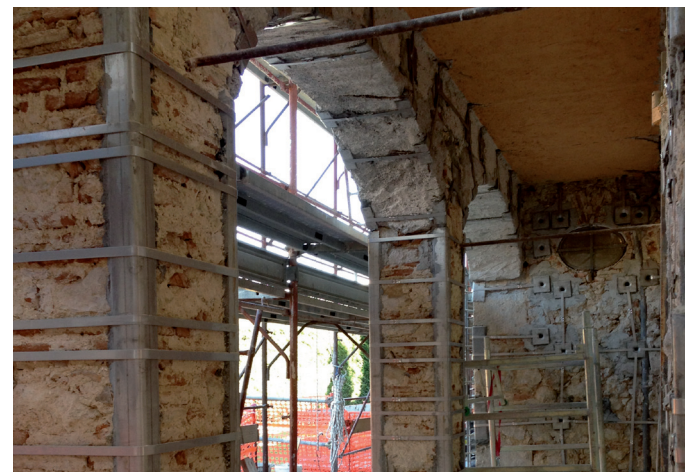
BORGO RIVERA (AQ): INTERVENTO DI RINFORZO CON IL CAM SUGLI ARCHI
