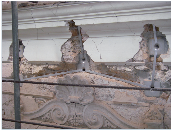
PALAZZO GALLI MARINUCCI: OPERAZIONE DI RINFORZO DELLA FACCIATA SENZA COMPROMISSIONE DEGLI ELEMENTI ARCHITETTONICI DI PREGIO
