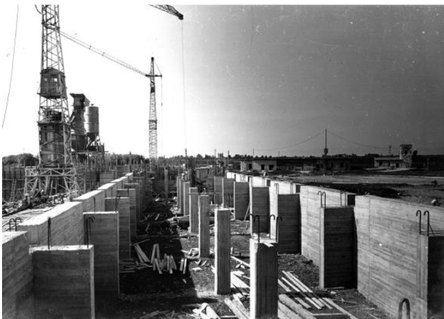
Figura 5. Foto d'epoca che mostra la geometria della struttura interrata.
