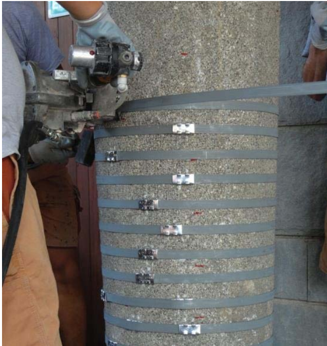
Figura 7. Applicazione del sistema CAM sui pilastri “a fungo”, preventivamente bonificati.
