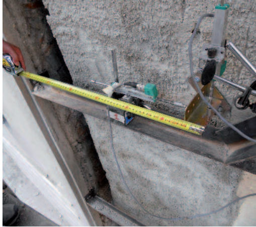
Figura 10 Posizionamento dei traduttori n. 1 e 2 sul telaio in acciaio.
