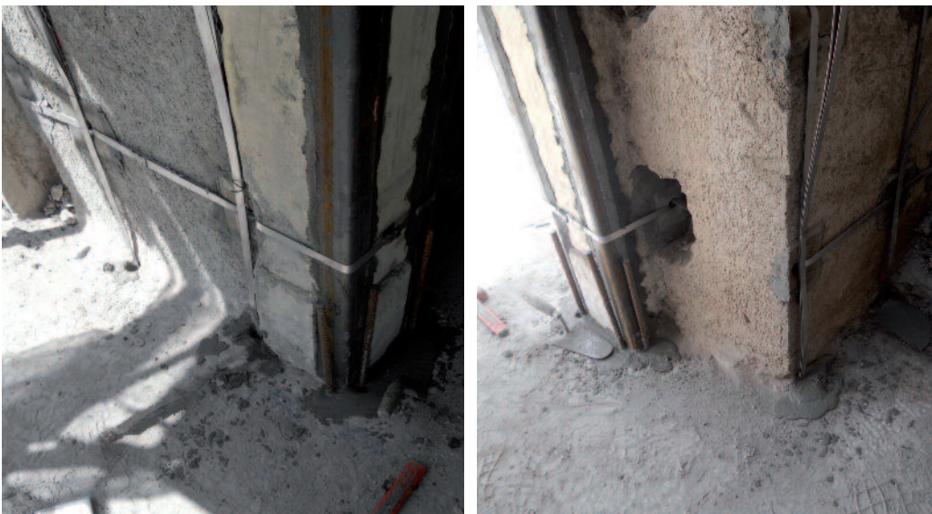
Figura 21 Inghisaggio dei nastri in acciaio e degli angolari alla fondazione.
