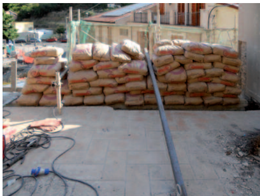
Figura 6 Posa in opera dell'intonaco (a sinistra).
