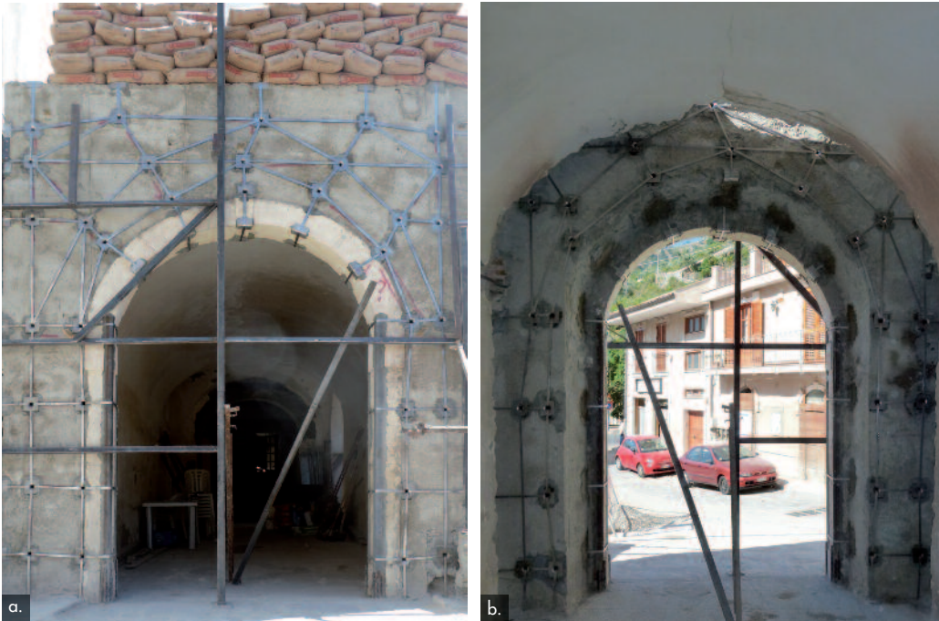
Figura 20 Arco rinforzato con CAM: a) vista esterna; b) vista interna.
