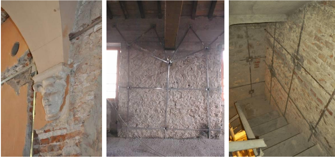
Figure 7 - Esempi di flessibilità distributiva del Sistema CAM
