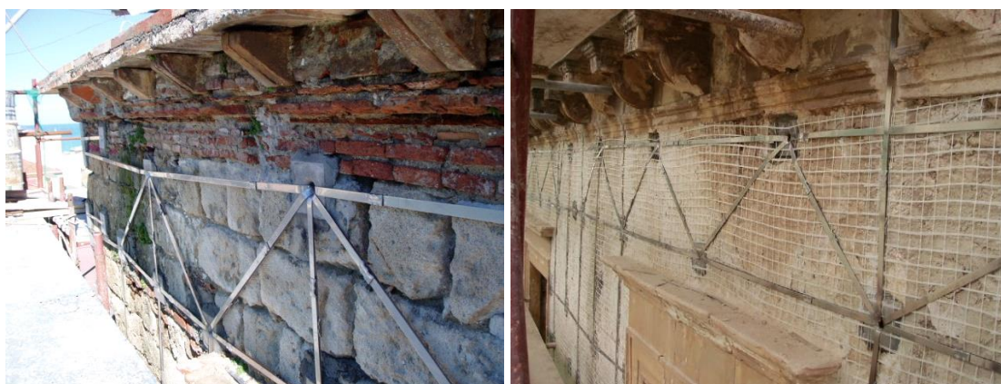
Figure 10 - Realizzazione del cordolo CAM
