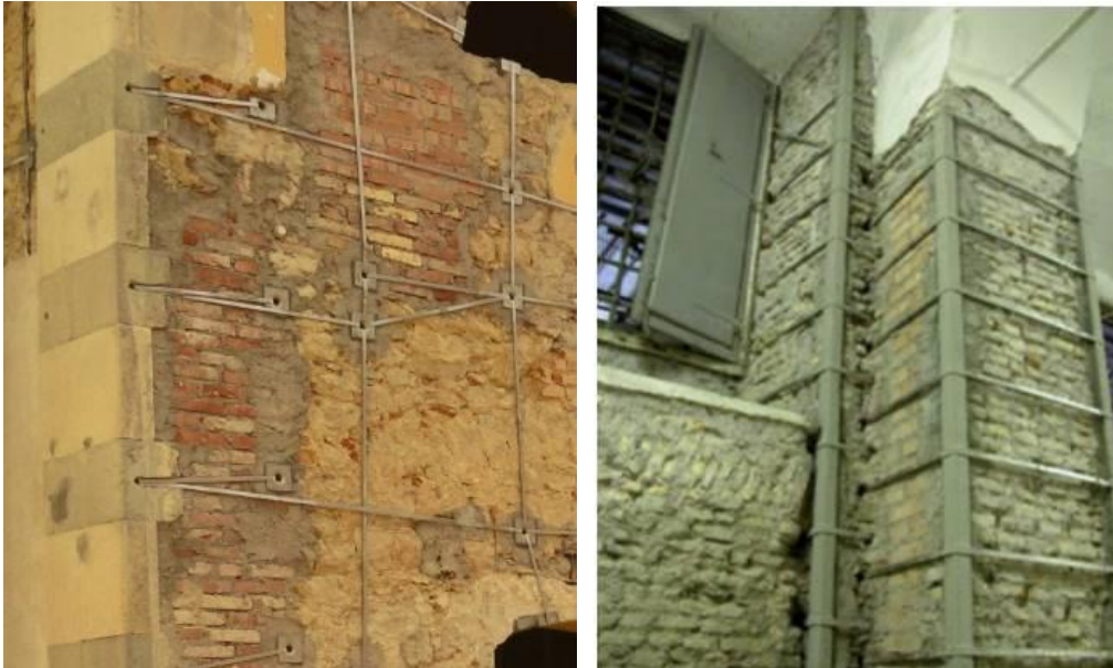
Fig. 13 - Ammorsature efficaci anche in presenza di cantonali in pietra a vista
