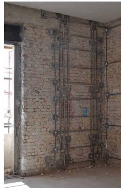
Figure 17 - Dominio di resistenza N-M di un pannello rinforzato e particolare di applicazione
