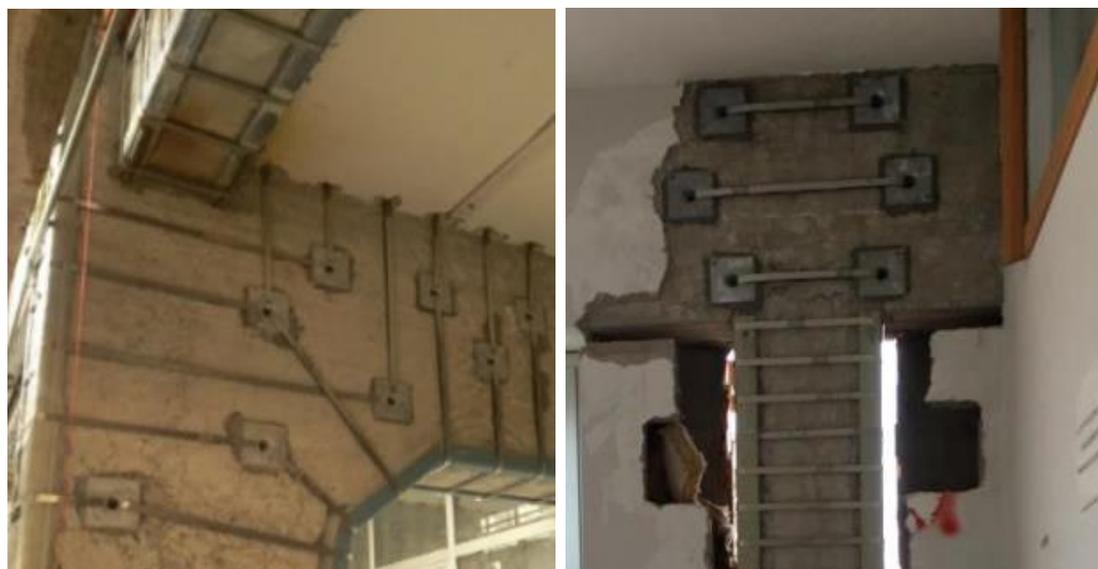
**Figura 19 – Edil CAM SISTEMI: Dettaglio di rinforzo di nodo eseguiti**
