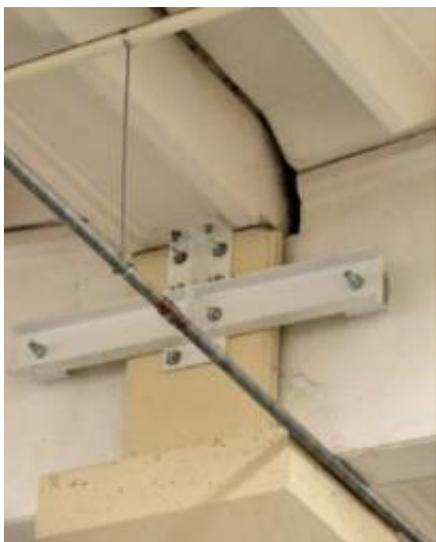
**Figura 23 – Carpenteria metallica per realizzazione dei vincoli**
