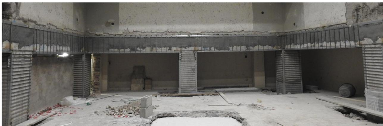
La struttura presentava numerose situazioni singolari, come travi curve, accoppiate, di geometria non regolare, oltre alla peculiarità della struttura ovvero la presenza di forti discontinuità in elevazioni con rastremazioni e sistemi di travature nelle due direzioni senza convergenza al nodo di pilastro.
