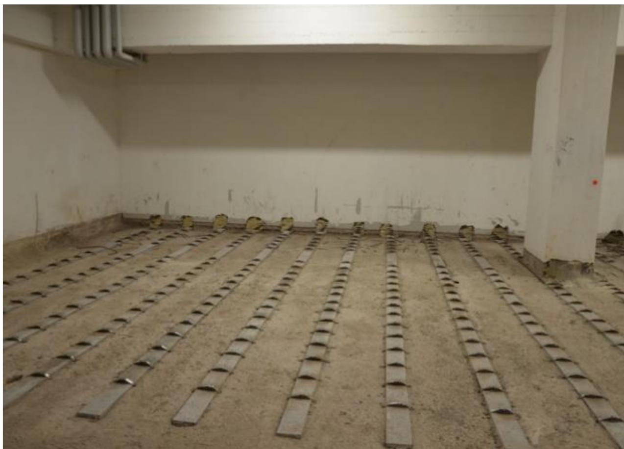
Il rinforzo CAM<sup>®</sup> è stato applicato ai travetti, disponendo piatti superiormente ed inferiormente e nastri a fasciare l'intera sezione del travetto, ottenendo in questo modo un incremento di resistenza a taglio. In corrispondenza degli appoggi, laddove fosse necessario il rinforzo a flessione, è stato disposto il piatto
