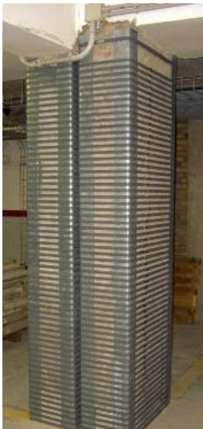
**Figura 6 – Edil CAM SISTEMI: rinforzo pilastri in corrispondenza di un giunto strutturale**
