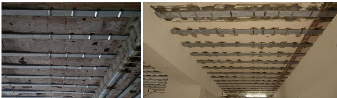
**Figura 21 - Edil CAM SISTEMI: vista intradosso rinforzo di solaio**
