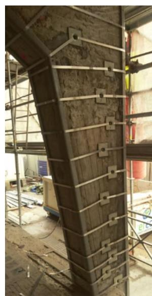
**Figura 12 – Pilastro di dimensione variabile durante le fasi di applicazione di posa e tesatura del nastro**
