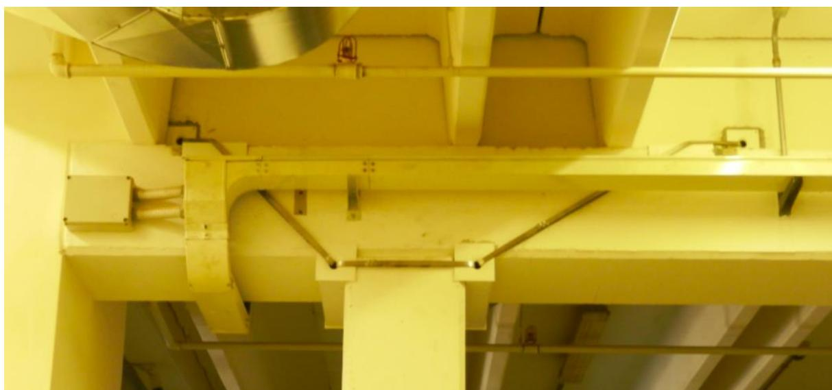
*Figura 29 – Edil CAM SISTEMI: interventi di connessione pilastro-trave*
