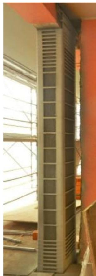
**Figura 8 - Edil CAM SISTEMI: Pilastro con 'staffatura' maggiorata nelle zone critiche**
