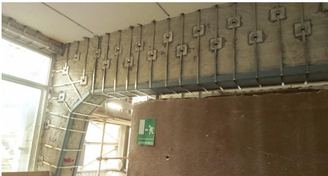
**Figura 17 – Vista all'intradosso di una trave alta: si possono realizzare fori intermedi nella trave per andare a costituire staffe a più braccia (principalmente nel caso di travi a spessore) o per incrementare il confinamento della sezione.**
