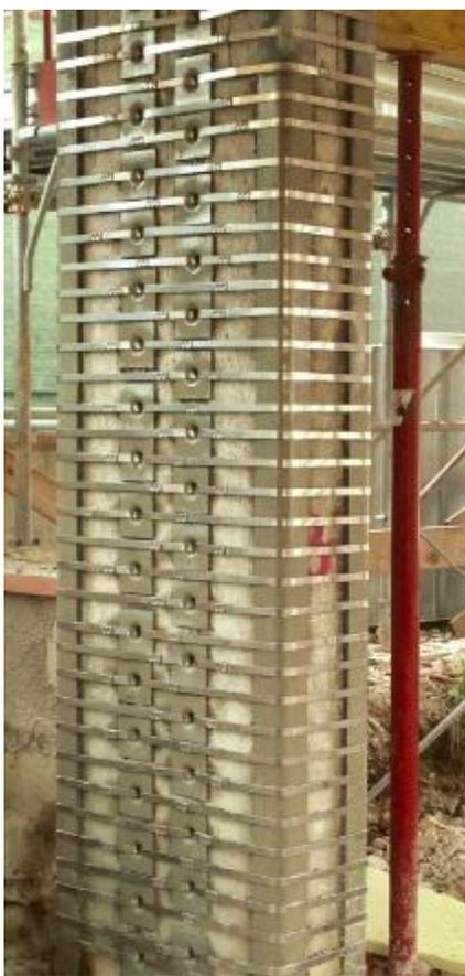
**Figura 7 - Edil CAM SISTEMI: Pilastro con 'staffatura' a più braccia**
